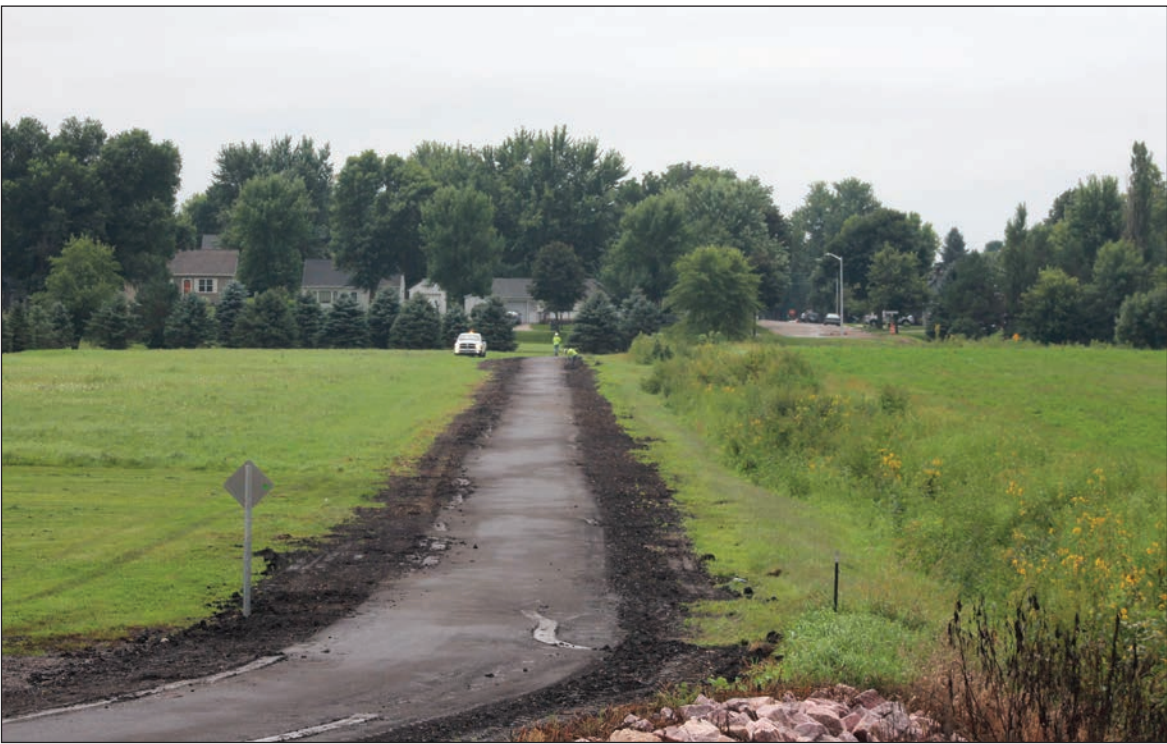
Lori Sorenson photo/0830 luverne loop phase 2
